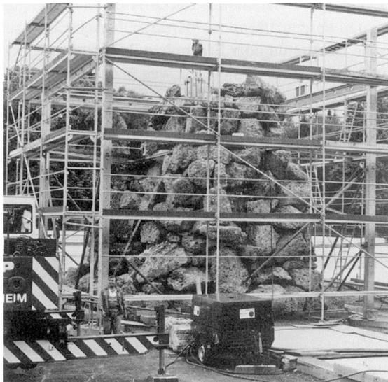
**Abb. 4:** Höhenverstellbares Schnurgerüst
