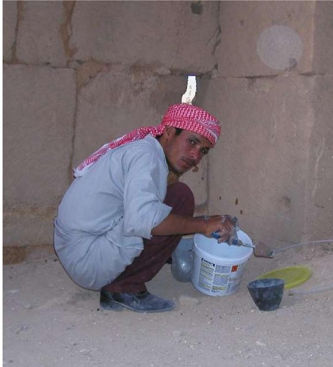
**Abb. 3.6** Einmörteln der Objektpunkte in der Basilika A
